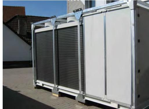
**WRK 300L-2-E-P- Kaltwassersatz mit 300 kW**
